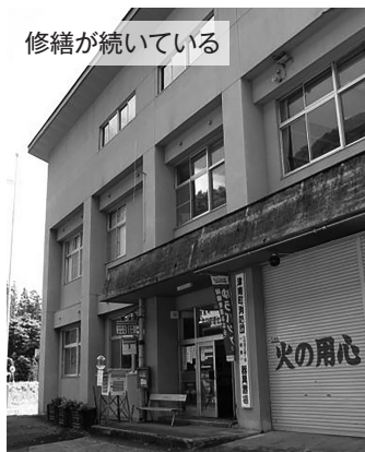
老朽化が進む公共施設
